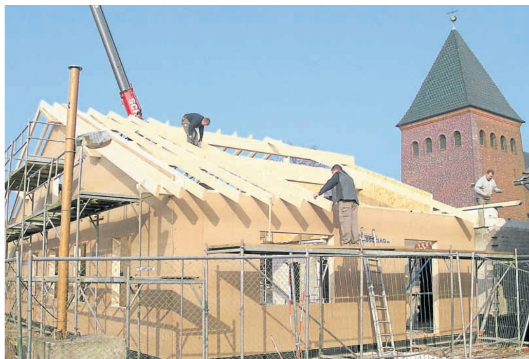
Die Erweiterung des Rohbaus entstand in einer Holzständerwerkkonstruktion.
